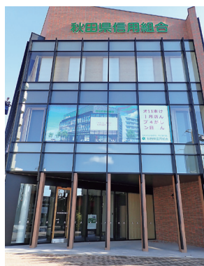
本店入口から見たサイネージの様子
