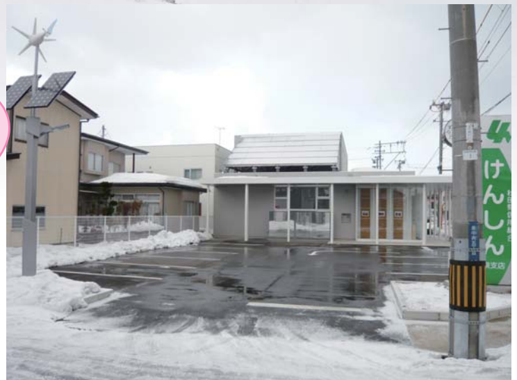
けんしん泉支店：舗装体加熱方式—温水パイプ—ペレットボイラー利用です。
